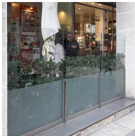
Figura 2. Foto tamponamento verticale
